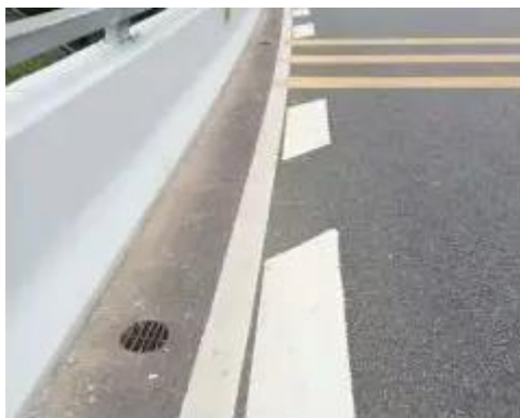
图4-3 匝道桥面泄水孔
