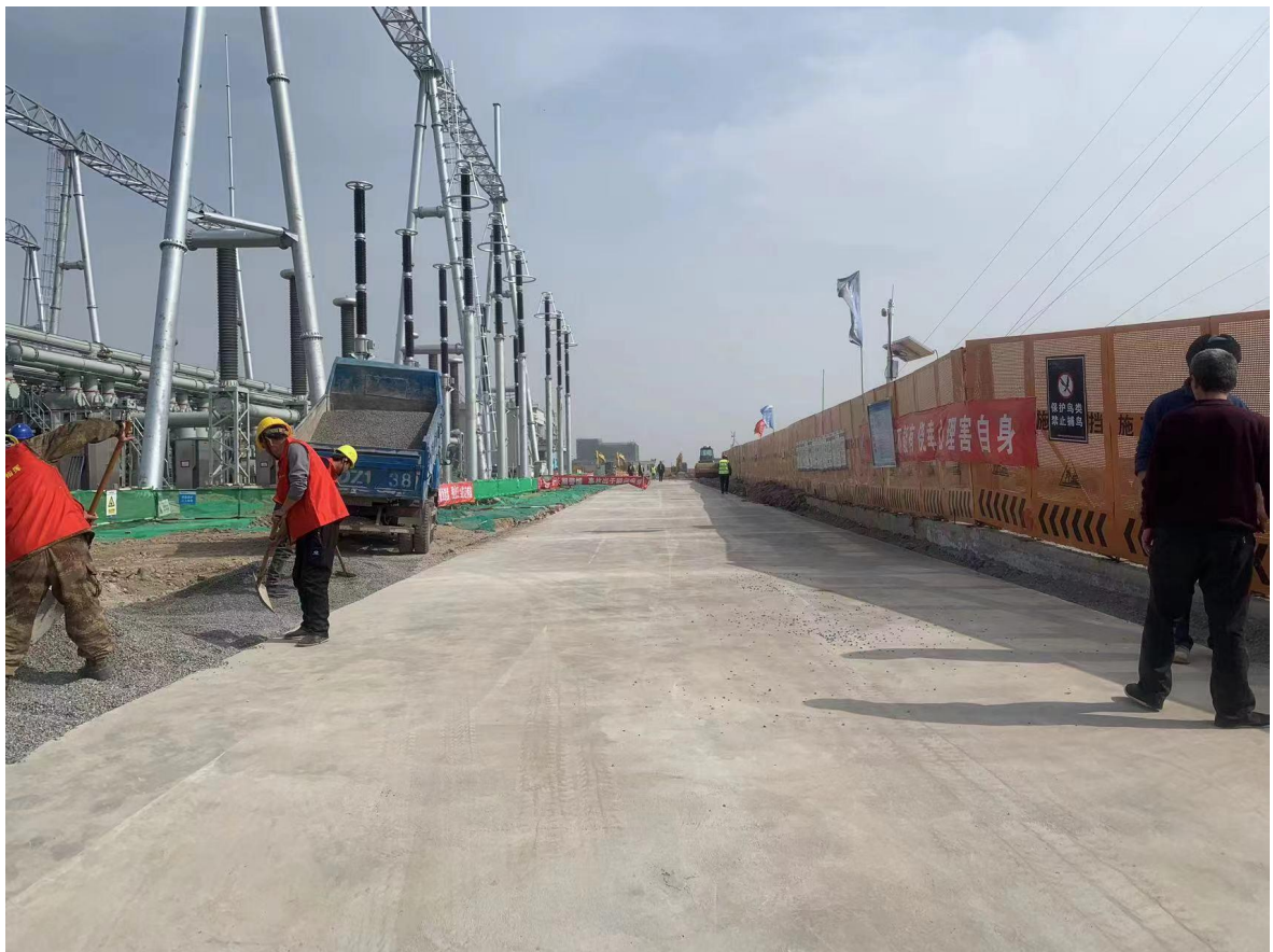
升压站路面清扫
