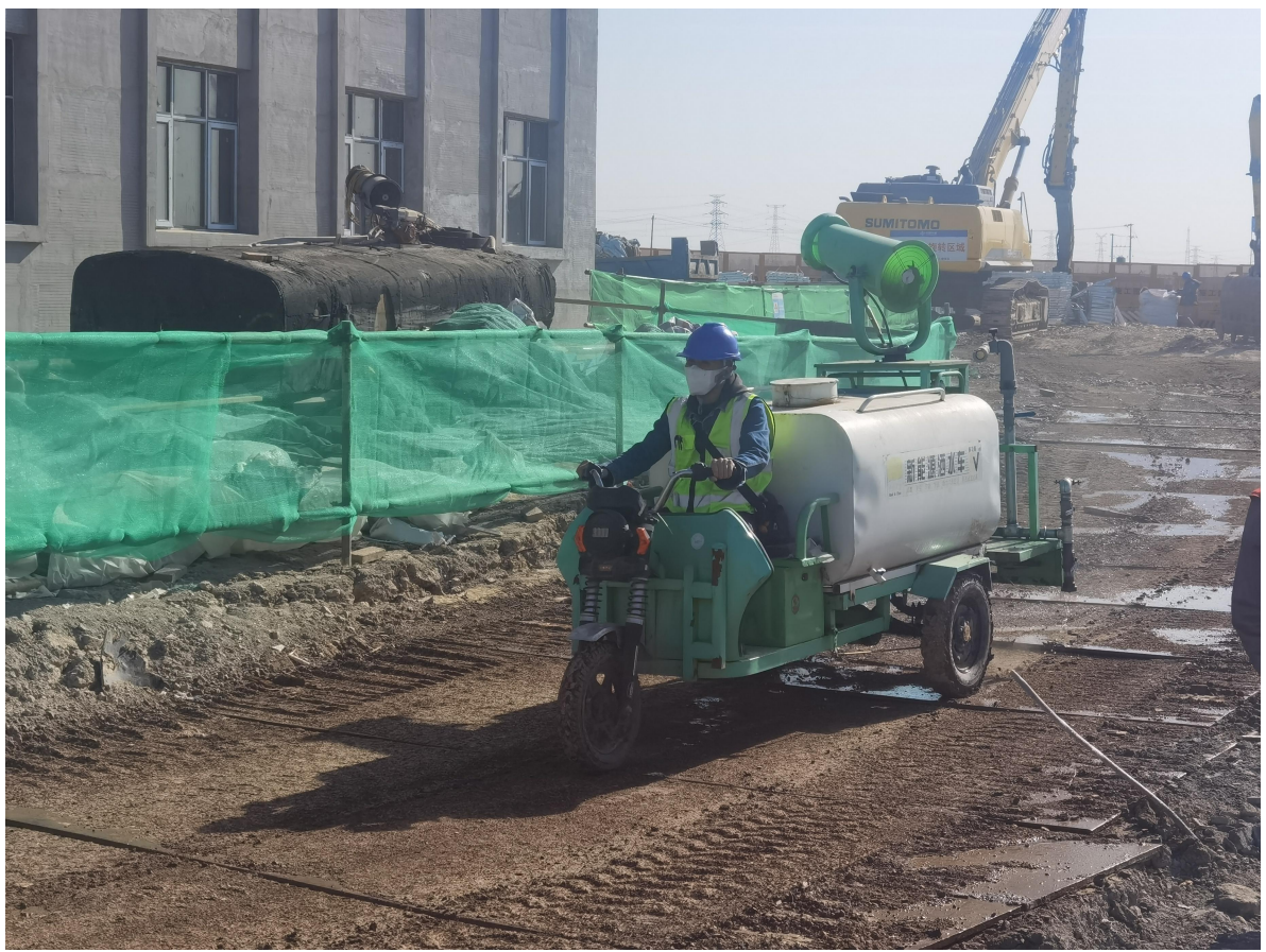
升压站洒水降尘
