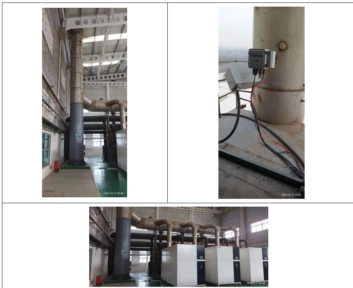
**图 3-1 燃气锅炉排气筒 P1 及其在线监测****(2) 废水污染物治理措施及排放**
