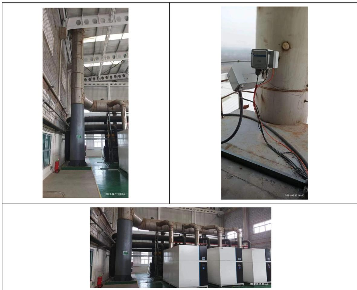
图 3-1 燃气锅炉排气筒 P1 及其在线监测
