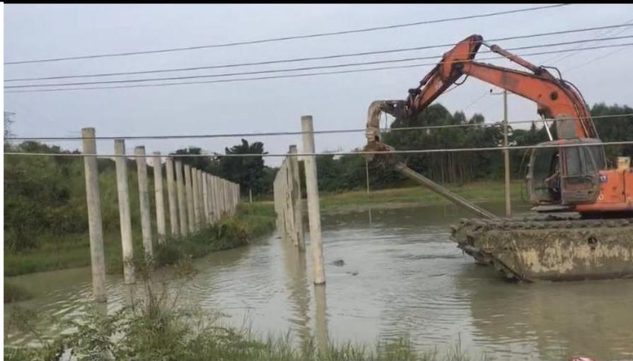
**图 2-13 陆挖机打桩施工图**
