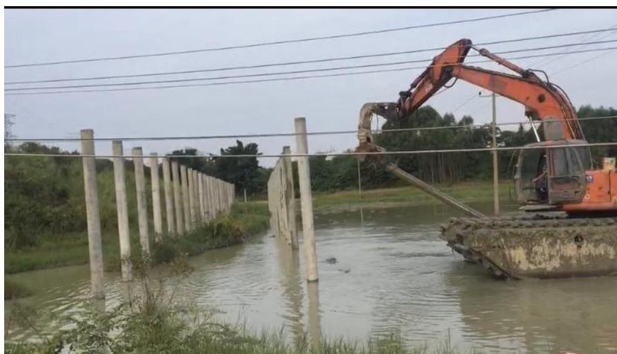
图 2-14 陆挖机打桩施工图
