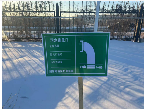
污水总排放口及标识牌
