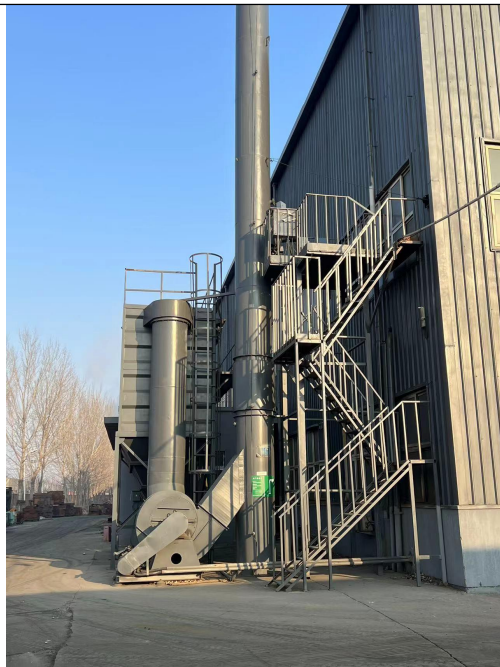
排气筒 DA009 采样平台
