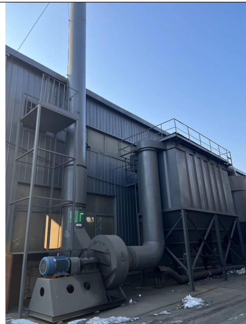
排气筒 DA002 采样平台
