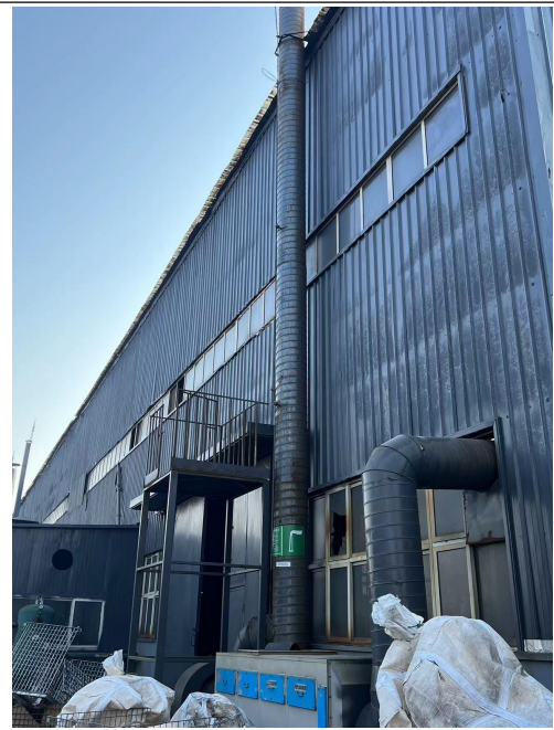
排气筒 DA006 采样平台
