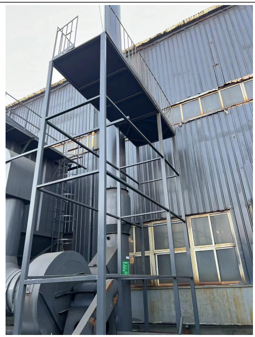
排气筒 DA010 采样平台
