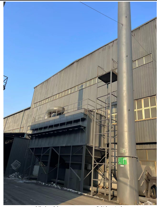
排气筒 DA004 采样平台
