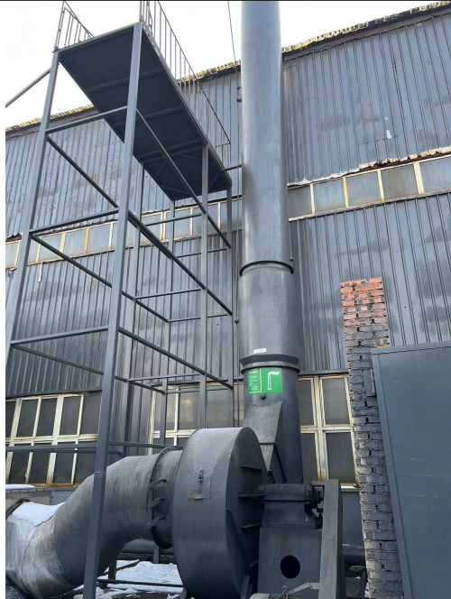
排气筒 DA007 采样平台
