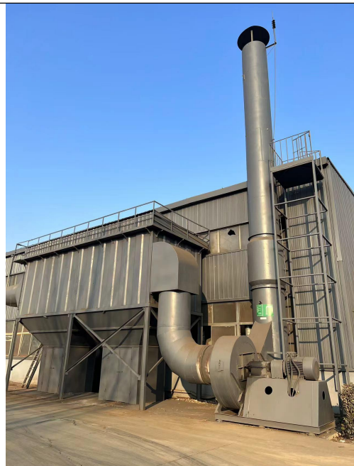
排气筒 DA001 采样平台
