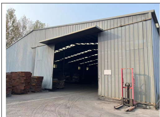
一般固废暂存间
