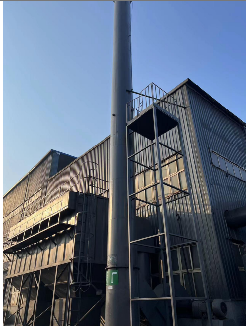
排气筒 DA005 采样平台
