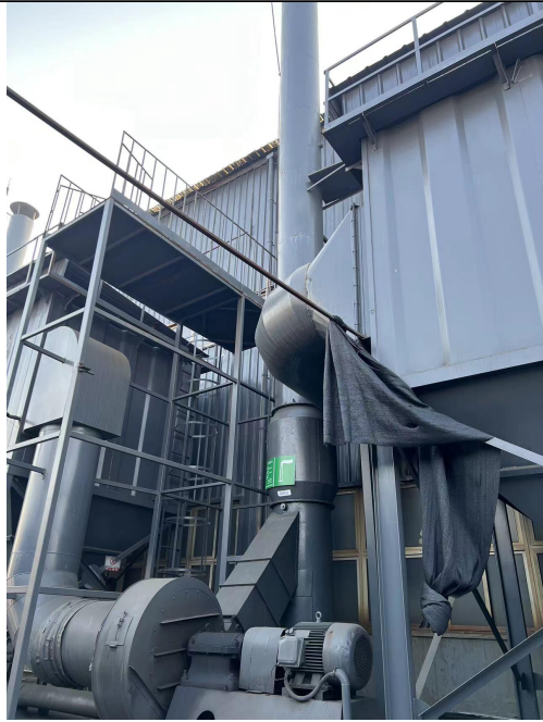
排气筒 DA003 采样平台
