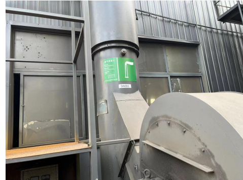
排气筒 DA002 (抛丸废气 P7)
