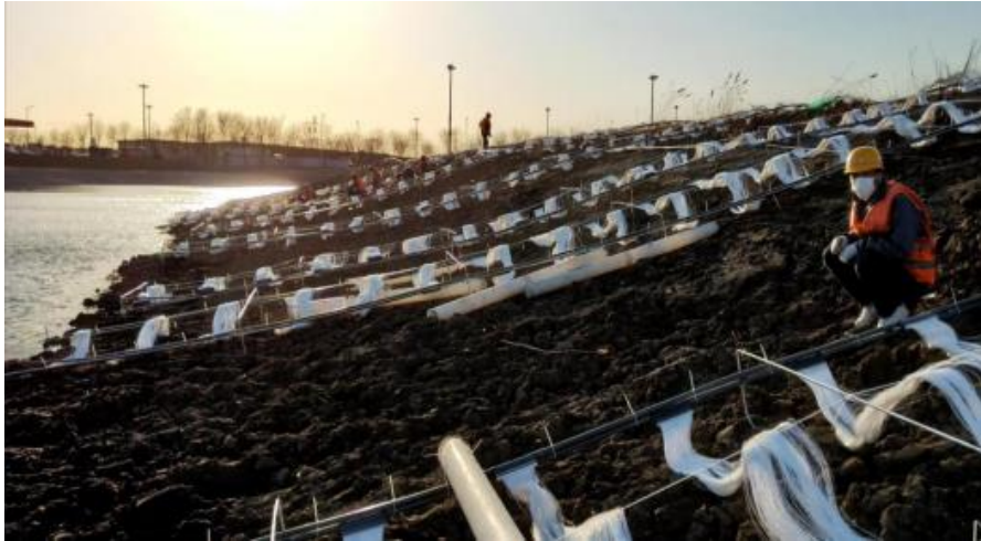
图 2-6 MABR 组件安装示意图
