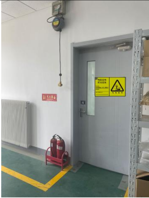
危废暂存间外部
