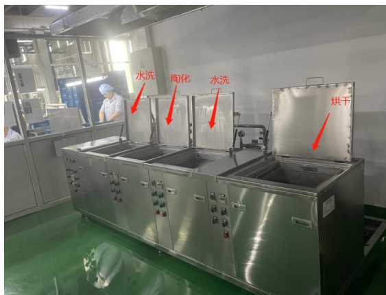
图 2-5 本项目所依托前处理线各槽体实景图
