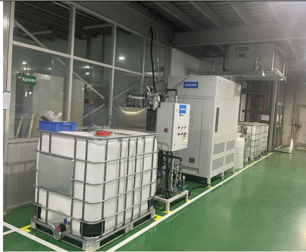
图 4-2 现有厂区一体式污水处理设备 (0.4m 3 /d)
