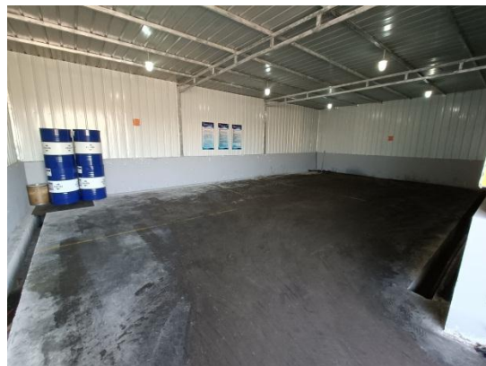
危废暂存间及其内部情况
