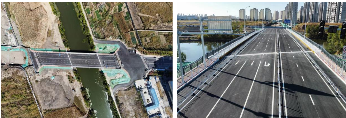
图 2.6-1 建设项目现状
