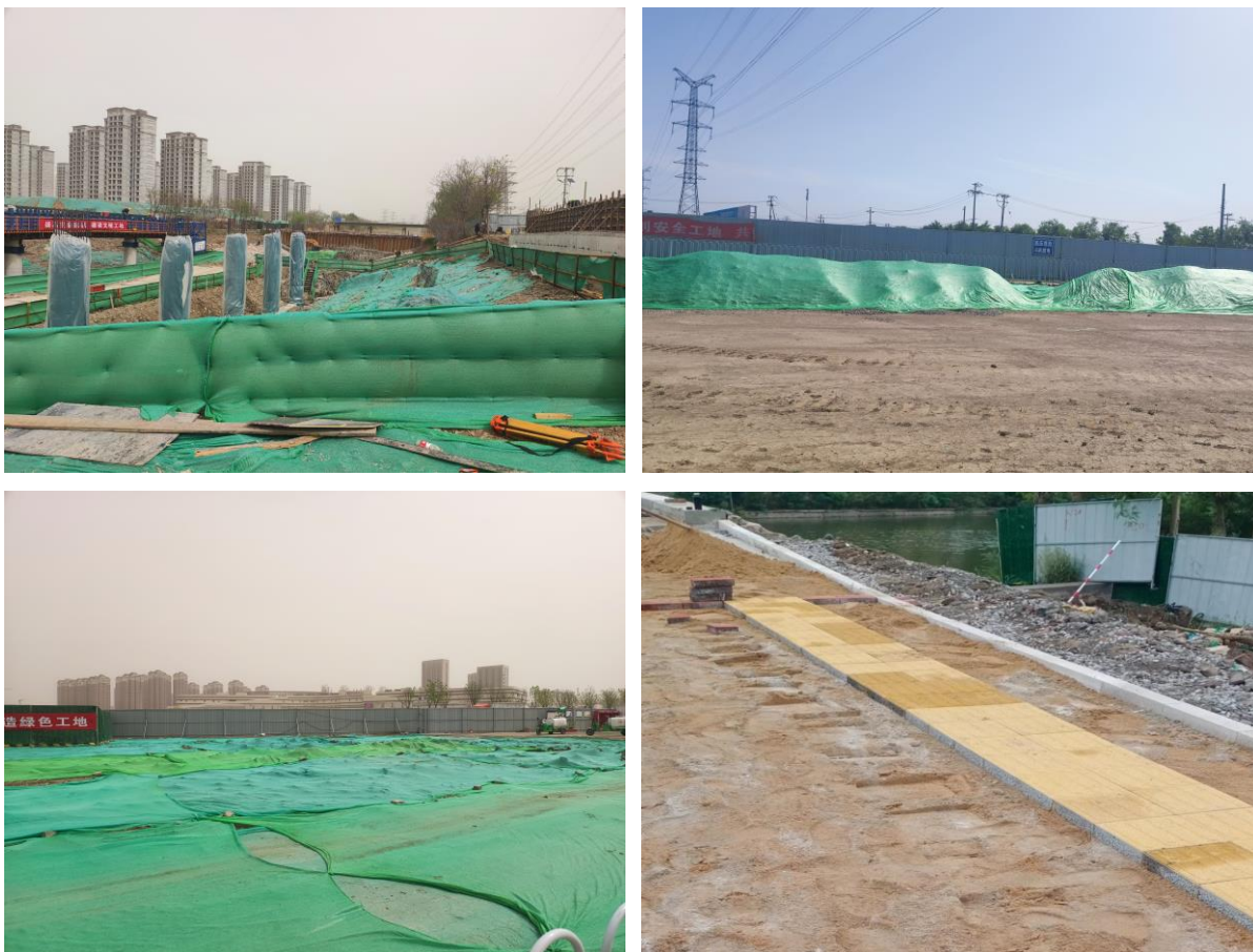
图 3.2-1 已实施水土保持措施现场实拍图片
