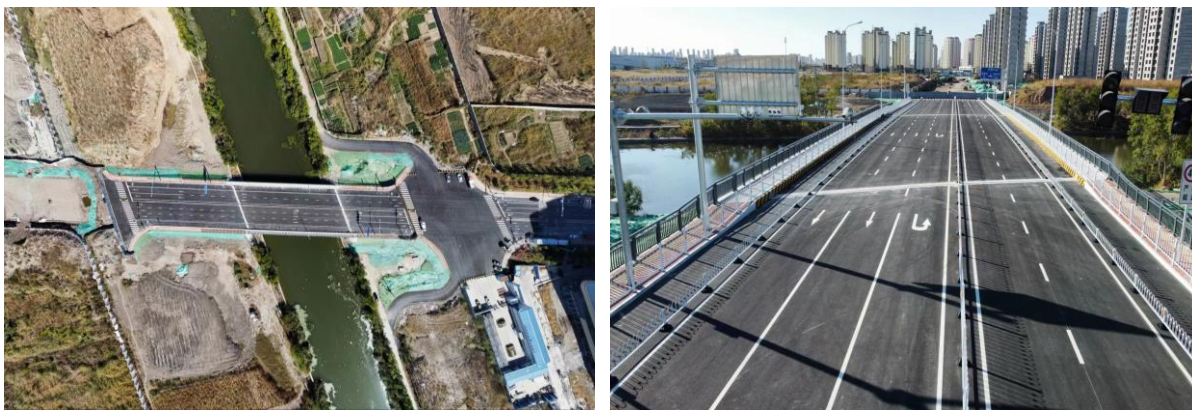
图 1.1-1 建设项目现状
