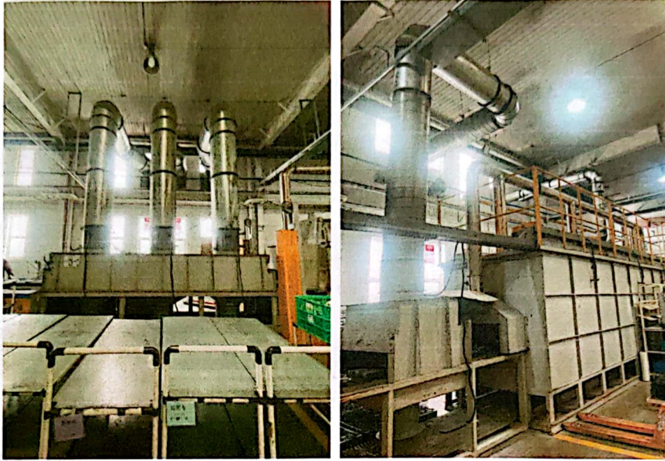
钎焊过程废气收集方式
