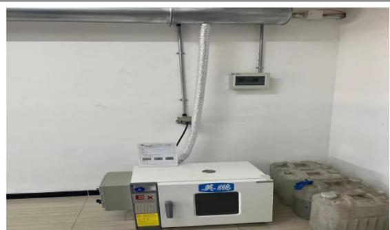
老化实验室废气密闭收集管道
