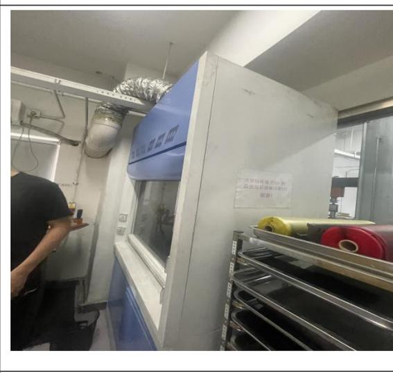
化学实验室通风橱及废气收集密闭管道
