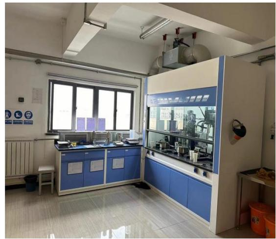
胶水实验室胶水称重及废气收集方式
