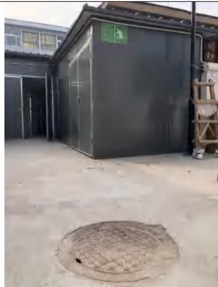
罗平道污水排放口
