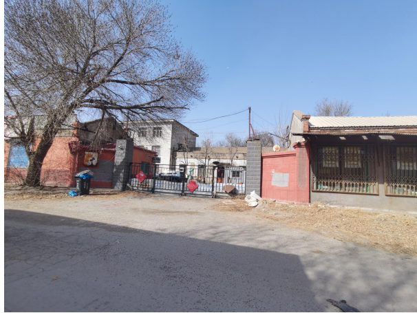
图 3-4 项目北侧待拆除地块（天津市扳钳工具九厂）
