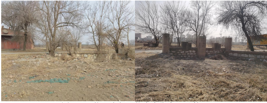
图2-2 现状西沟与现状南大街交叉处箱涵
