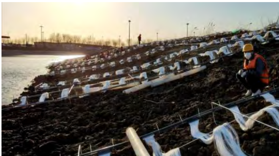
图 2-9 MABR 组件安装示意图
