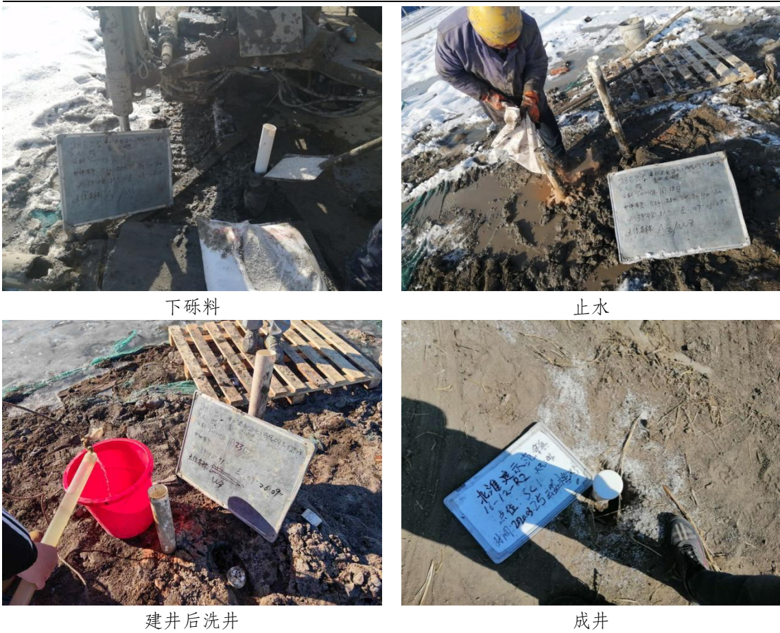
图 4.3 地下水监测井制作过程
