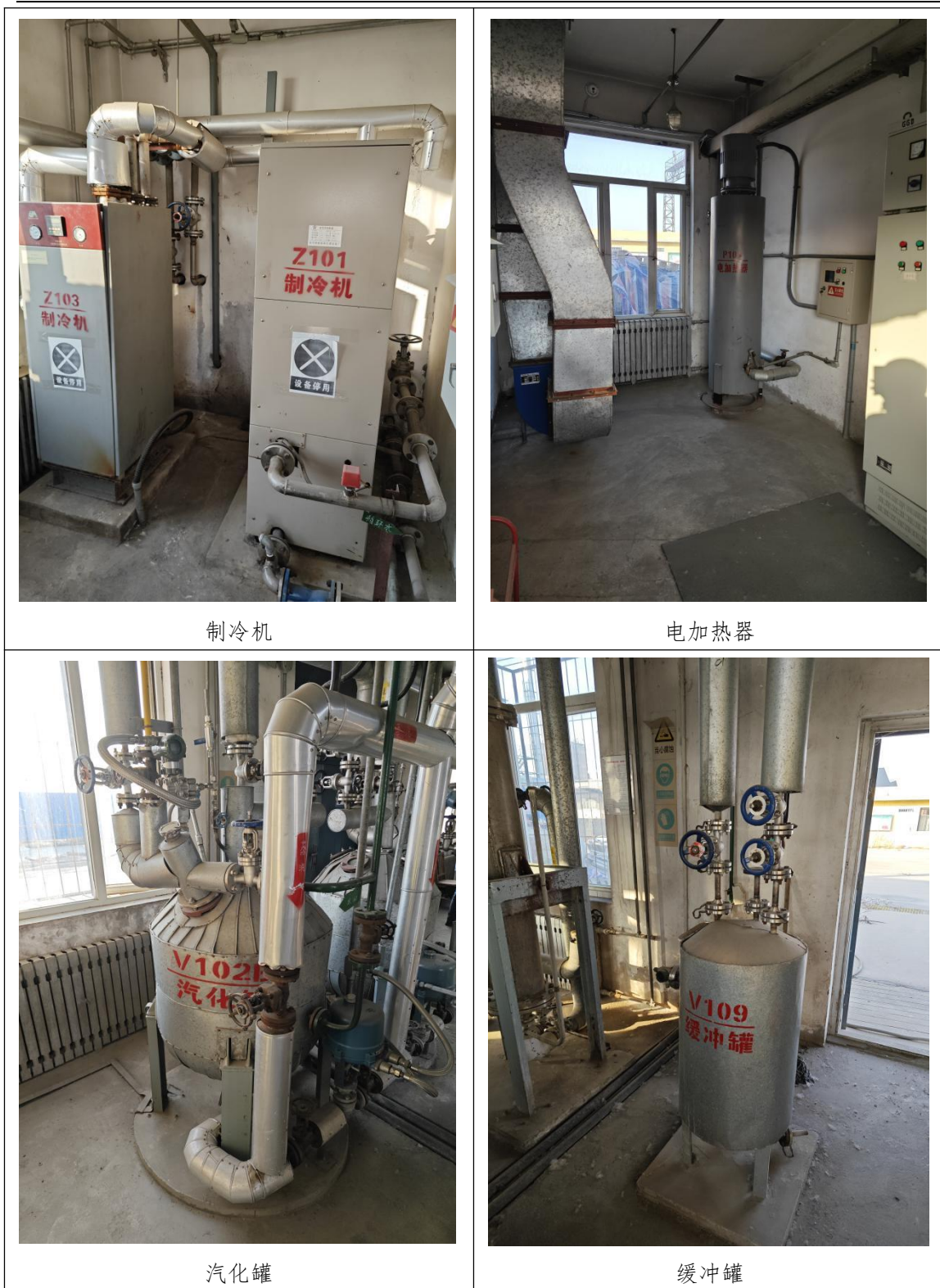
图 2.15 林圣金海拆除前照片
