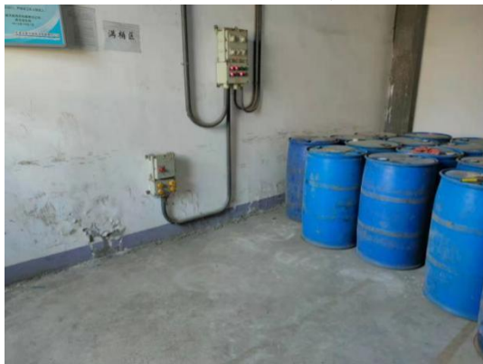
甲醇库内地面防渗
