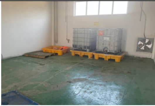
图 5-1 现有工程危废暂存间现状图
