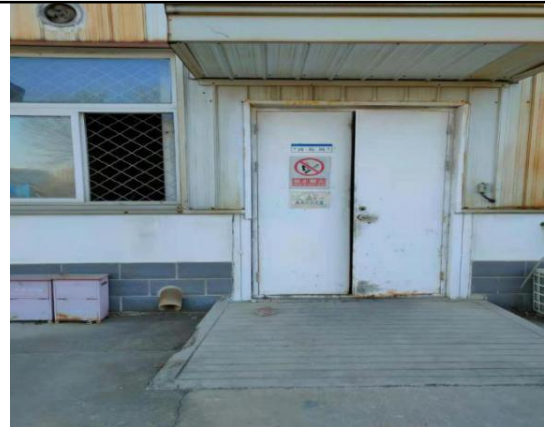
丙烷库门口围堰及缓坡
