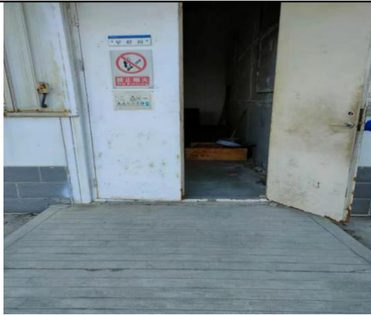
甲醇库门口围堰及缓坡
