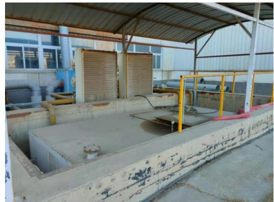
冷却油槽区域防渗
