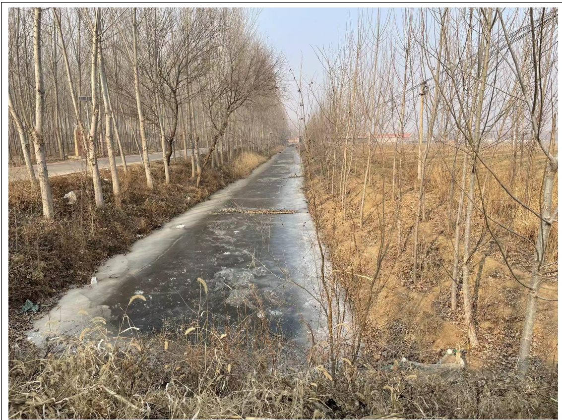
西白渠现场照片
