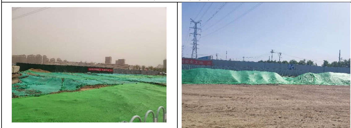
临时防护措施
