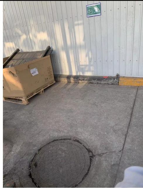
污水排放口标识牌
