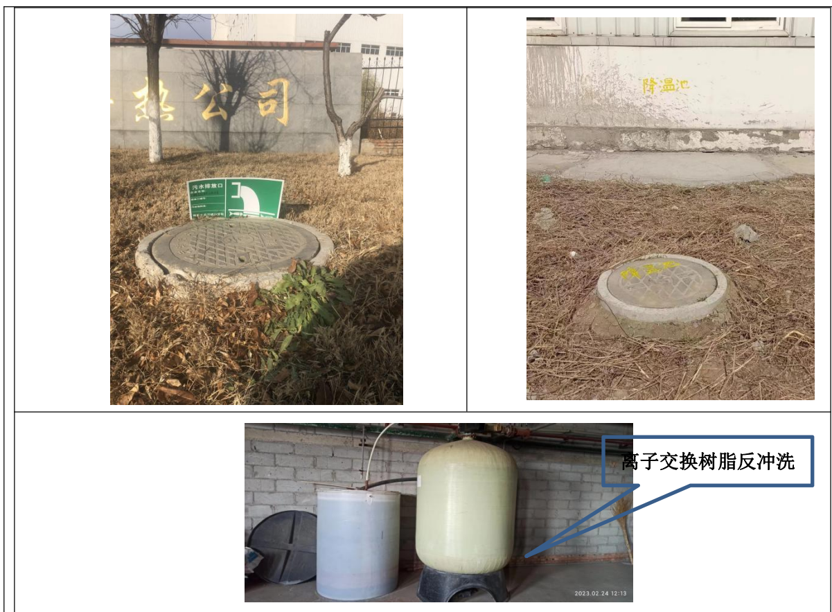
图 3-2 污水排放口及排污降温池
