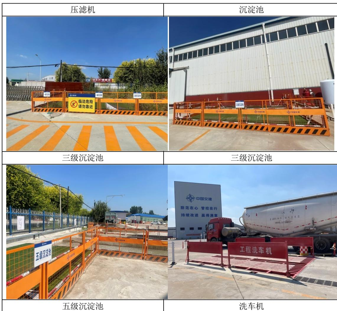
图 4-1 生产废水处理设施图
