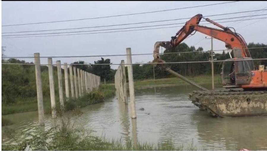
图 2-10 水陆挖机打桩施工图
