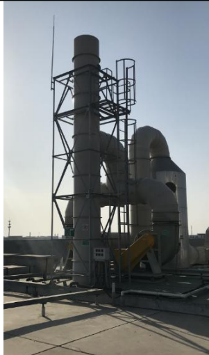
废气排放口 P30（酸性气体洗涤塔）
