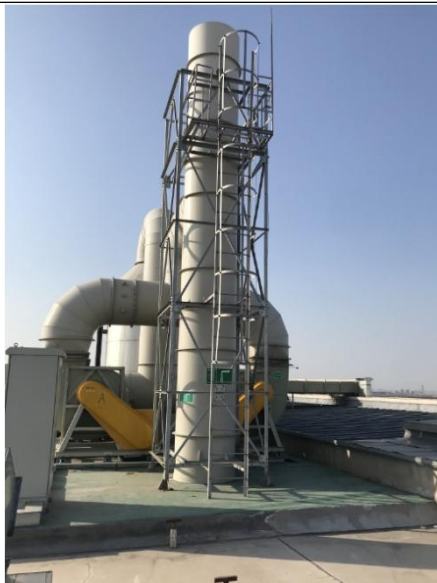
废气排放口 P29（酸性气体洗涤塔）
