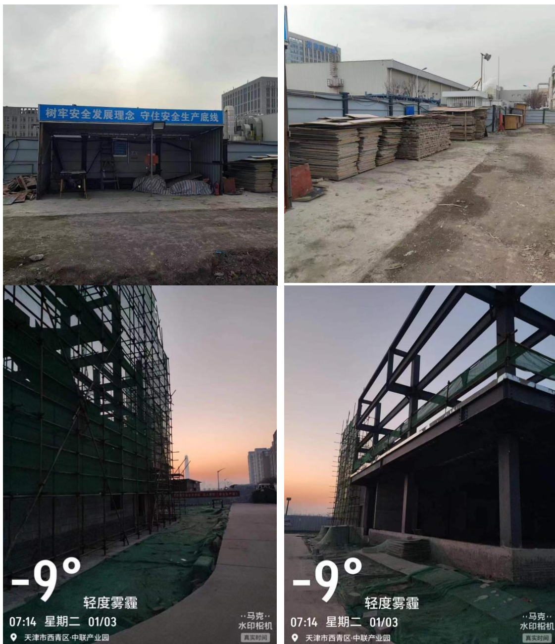
图 4-3 现场监测中临时防护措施图
