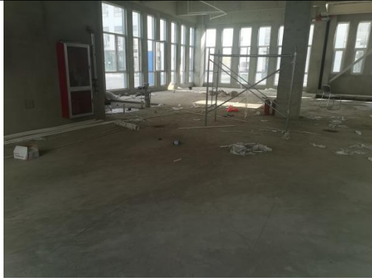
图 2-3 本项目厂区现状图
