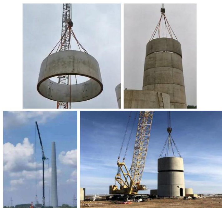
图 2-6 混塔吊装示意图
