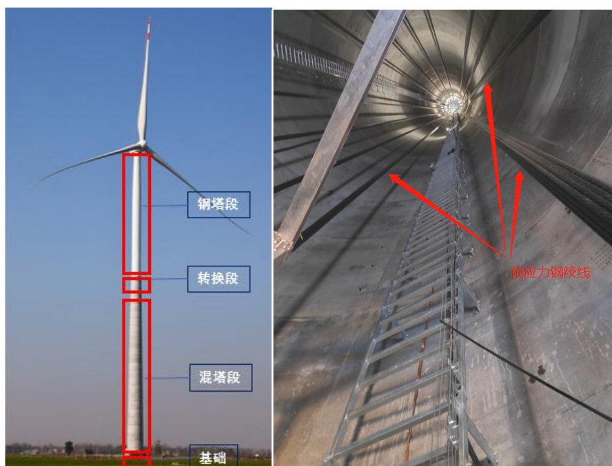
图 2-3 混凝土-钢混合塔筒示意图
