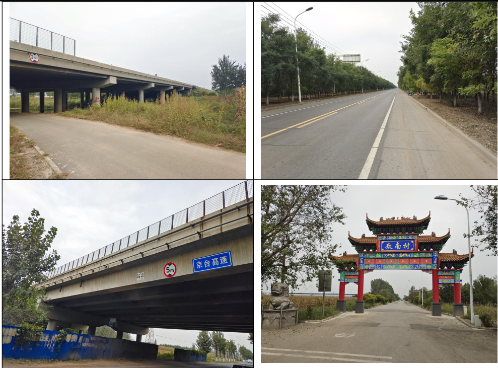
图 3-5 项目周边道路调查照片
