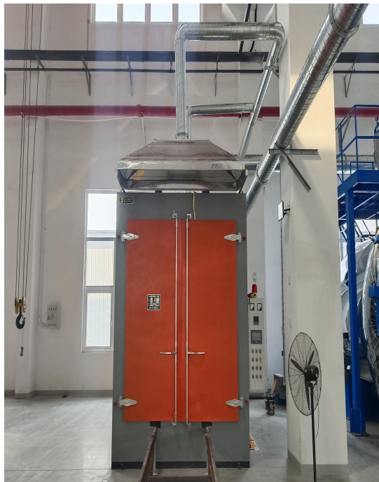
固化炉废气收集方式
