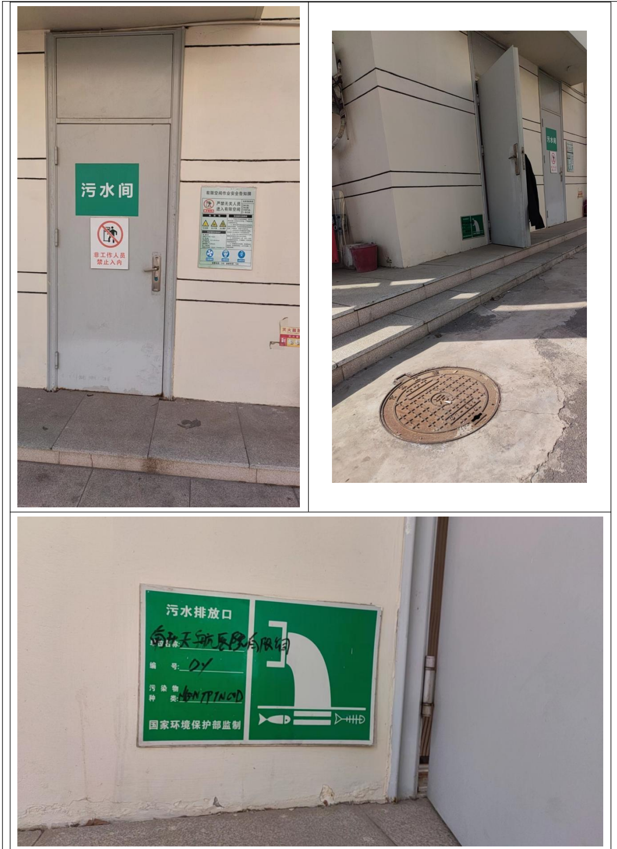
图 3-2 污水排放口及污水处理站
