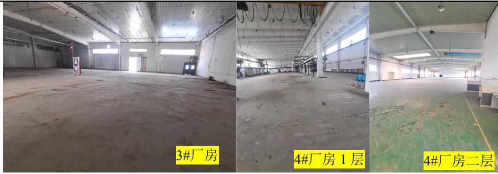
图 2-4 本项目厂区及厂房现状图
