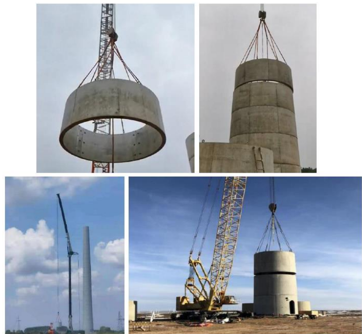
图 2-6 混塔吊装示意图
