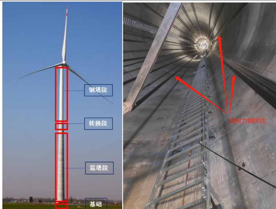
图 2-3 混凝土-钢混合塔筒示意图
