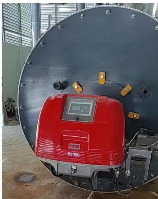
导热油炉低氮燃烧器
