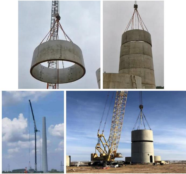
图 2-5 混塔吊装示意图
