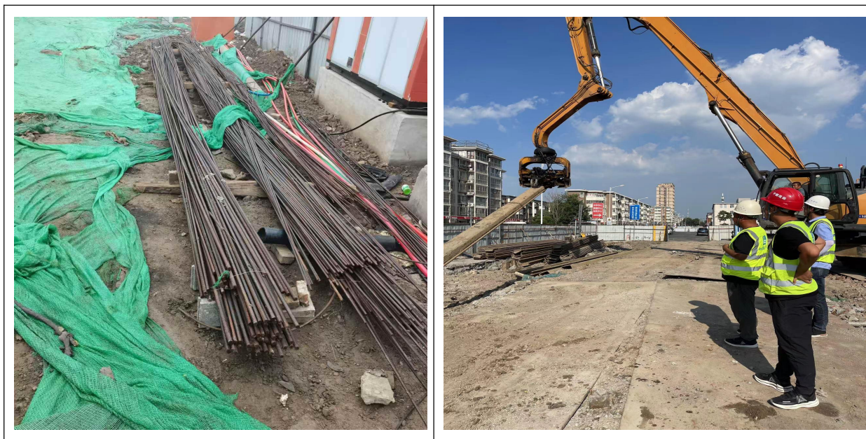
图 2.2-1 项目施工生产区
