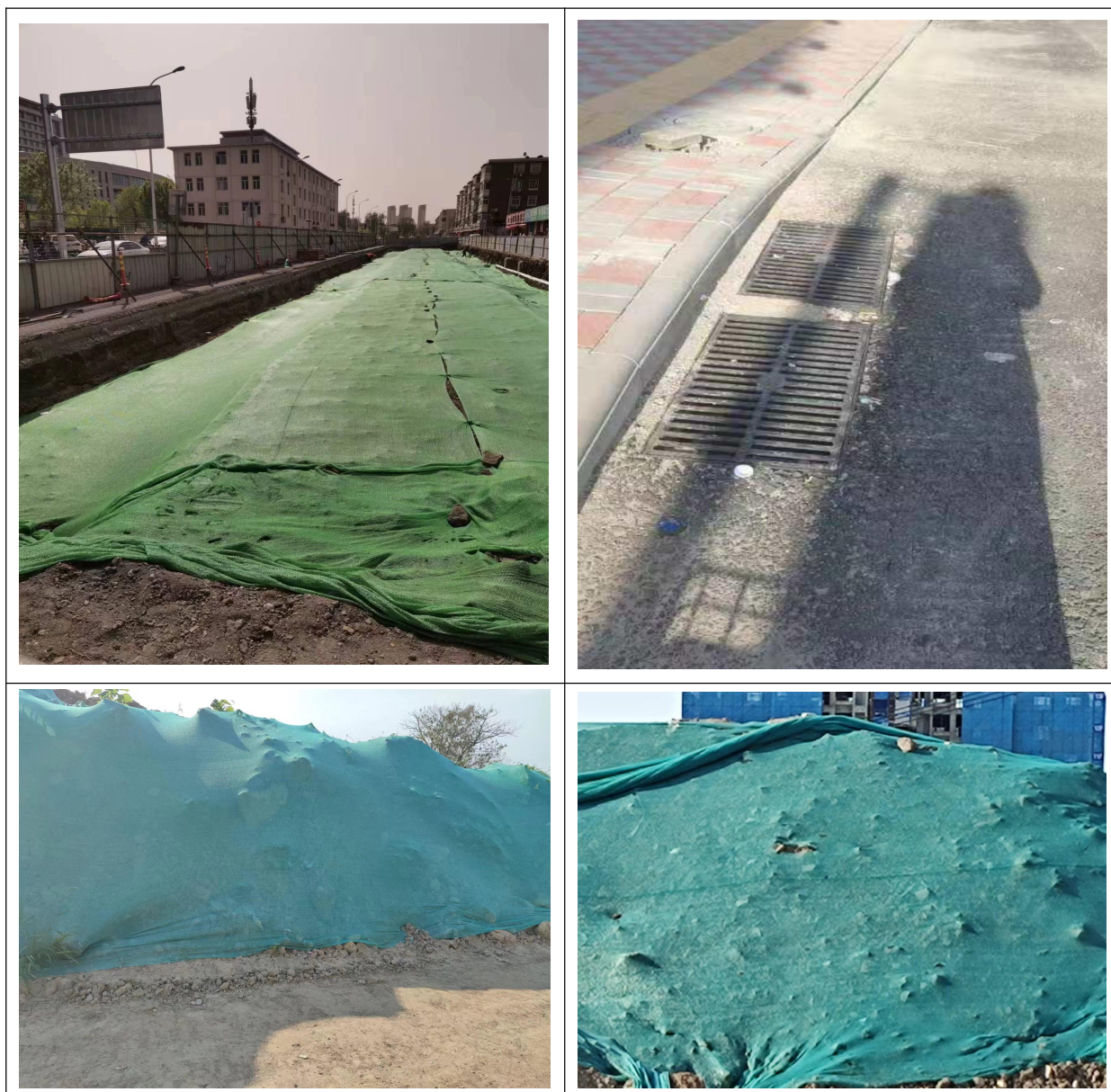
图 3.2-1 已实施水土保持措施现场实拍图片
