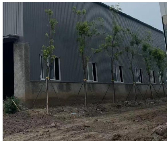
(b) 绿化施工
