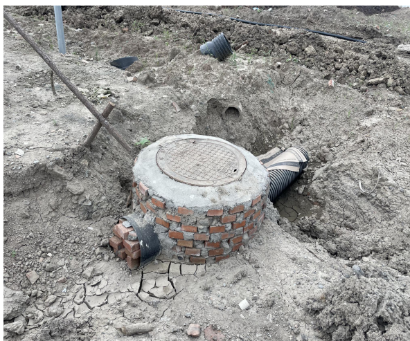
(c) 管网施工
