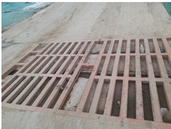
(a) 施工出入口洗车槽
