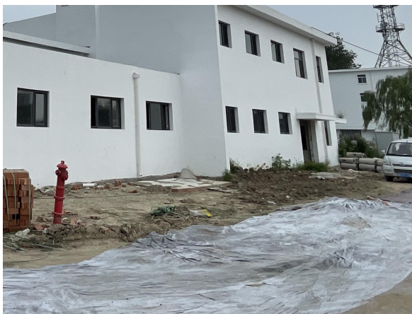
(b) 施工土工布苫盖
