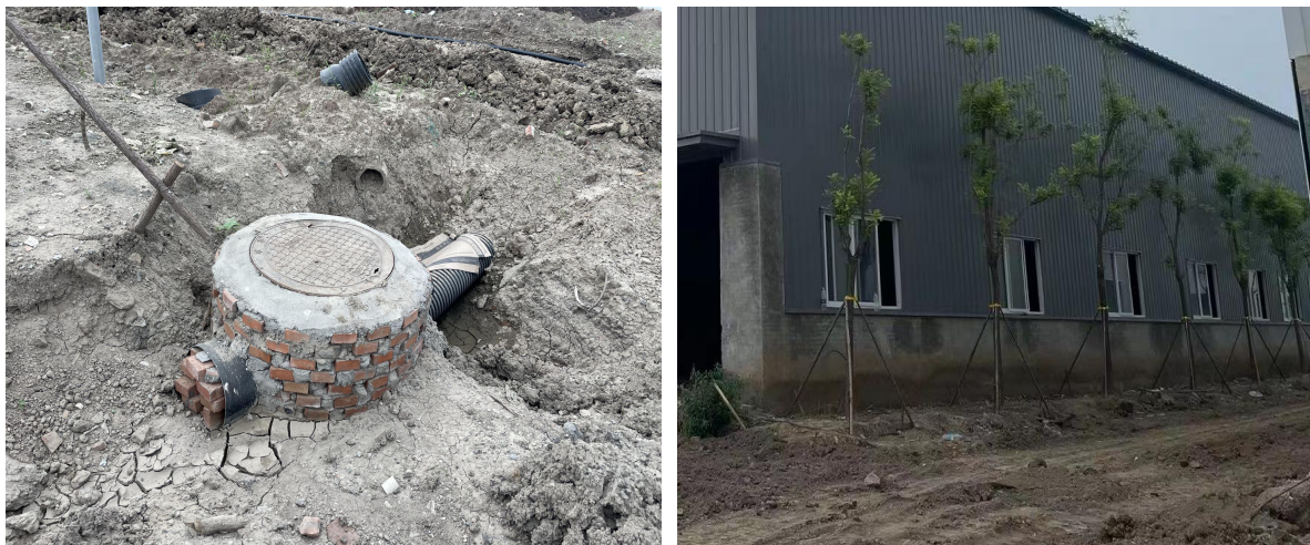
(c) 管网施工
