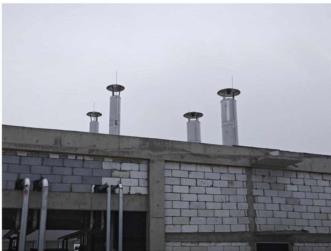
图 3-1 燃气锅炉排气筒 P1~P4
