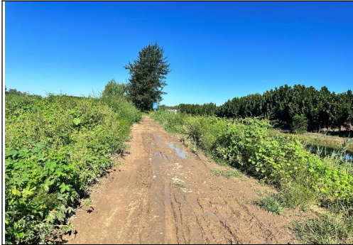
万达鸡场闸至南大跑马场段右堤现状堤顶土路
