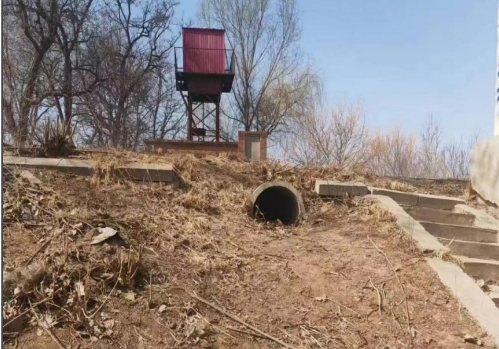
拆除口门现状情况
