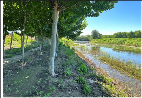
左堤现状堤顶树林
