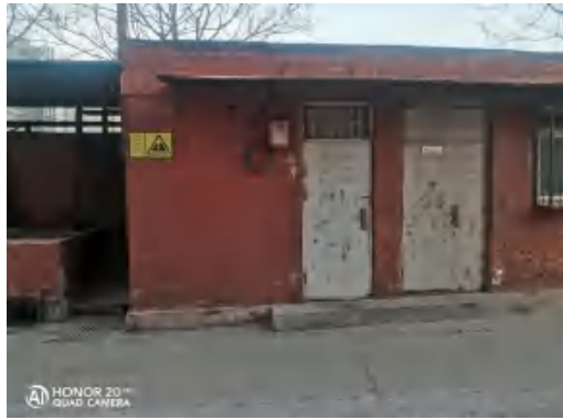
资阳路危废暂存间外部
