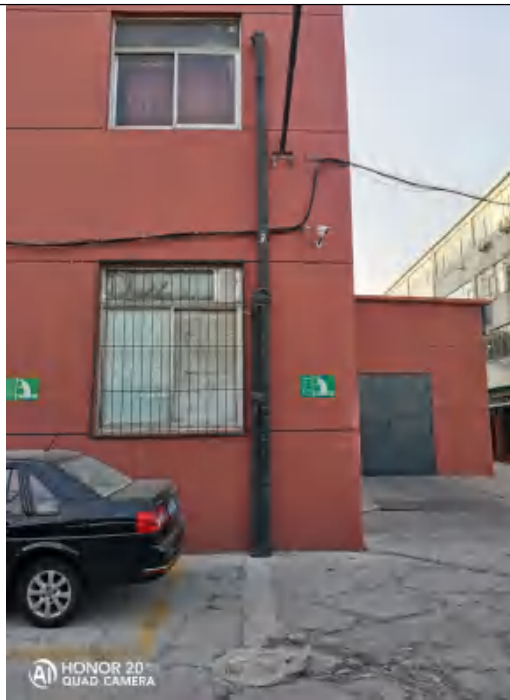
资阳路厂区污水排放口
