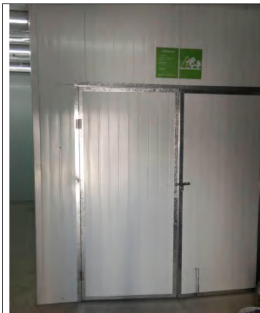
罗平道危废暂存间外部
