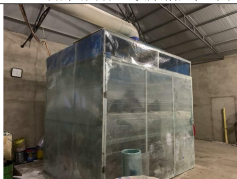
FRP 搅拌混合封闭间
