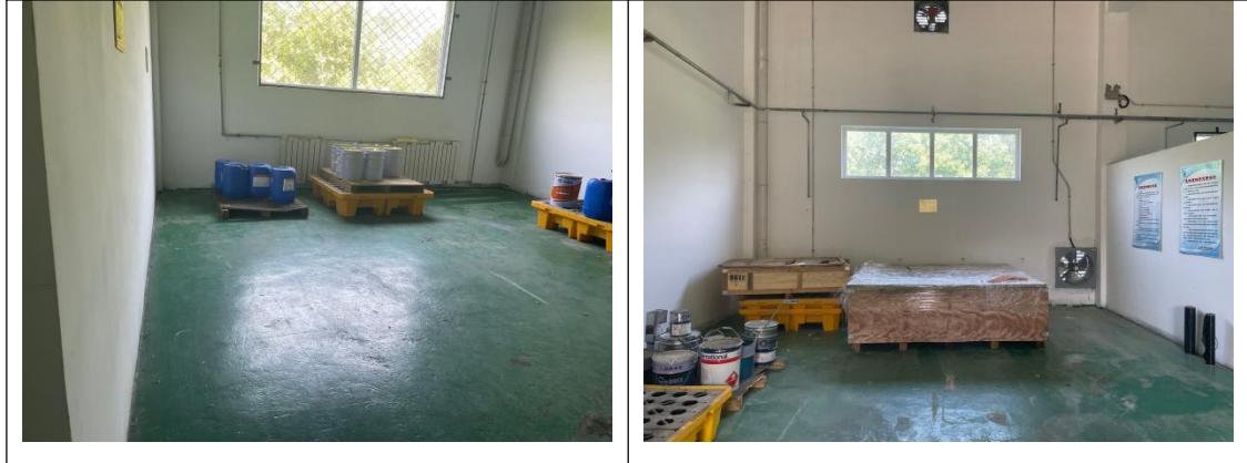
图 5-1 现有工程危废暂存间现状图
