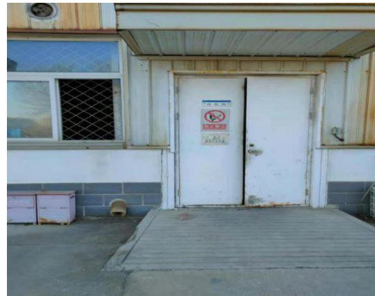
丙烷库门口围堰及缓坡
