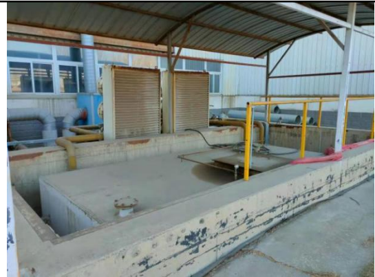
冷却油槽区域防渗
