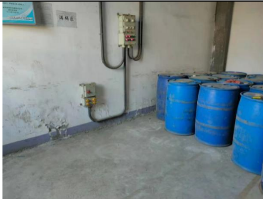
甲醇库内地面防渗
