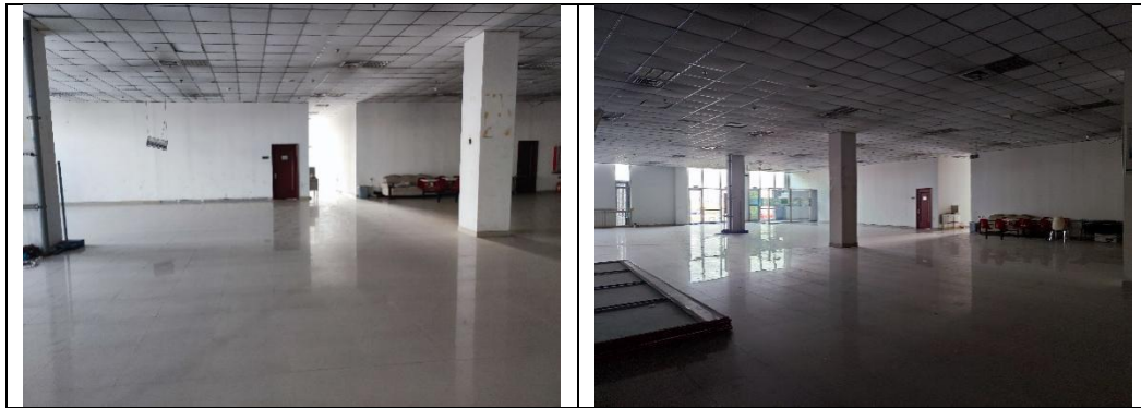
图 2-3 综合楼 1F 现状
