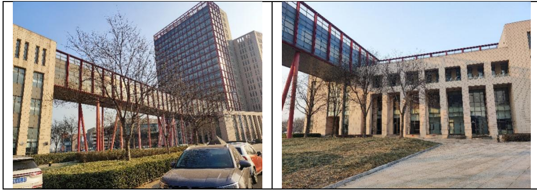
图 2-2 实验楼和综合楼连接情况
