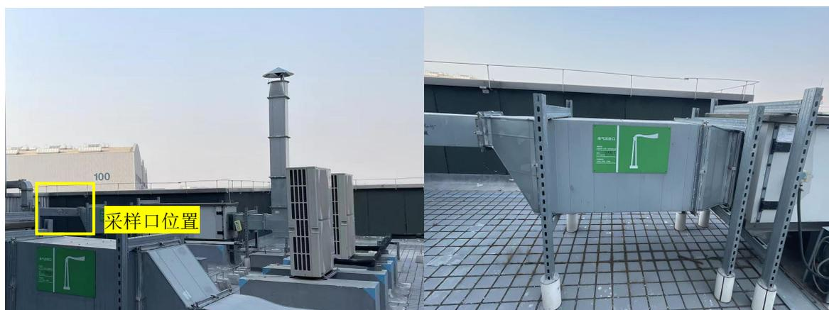
图4-1 P1排气筒及废气处理设施
