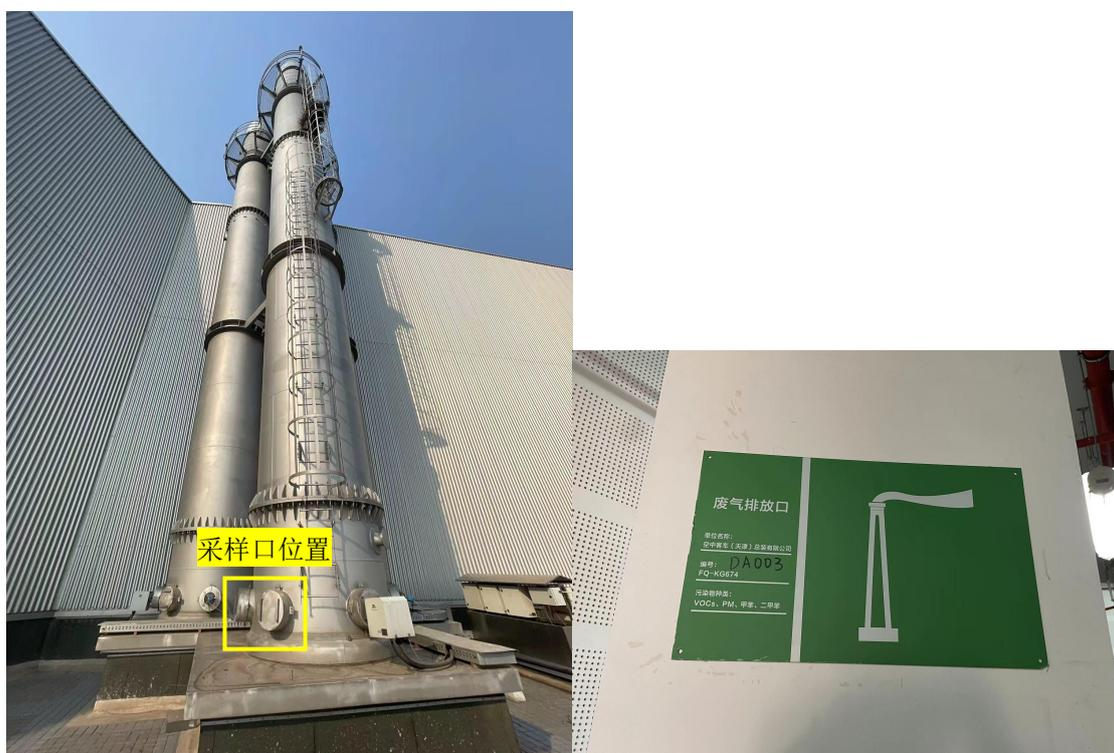
图4-3 P3 (P3-1、P3-2、P3-3) 排气筒及废气处理设施
