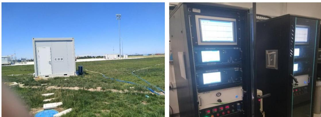
图 水质在线监测房及在线监测设备
