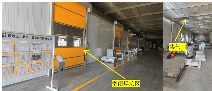
图 2-5 现有工程密闭焊接区及集气口
